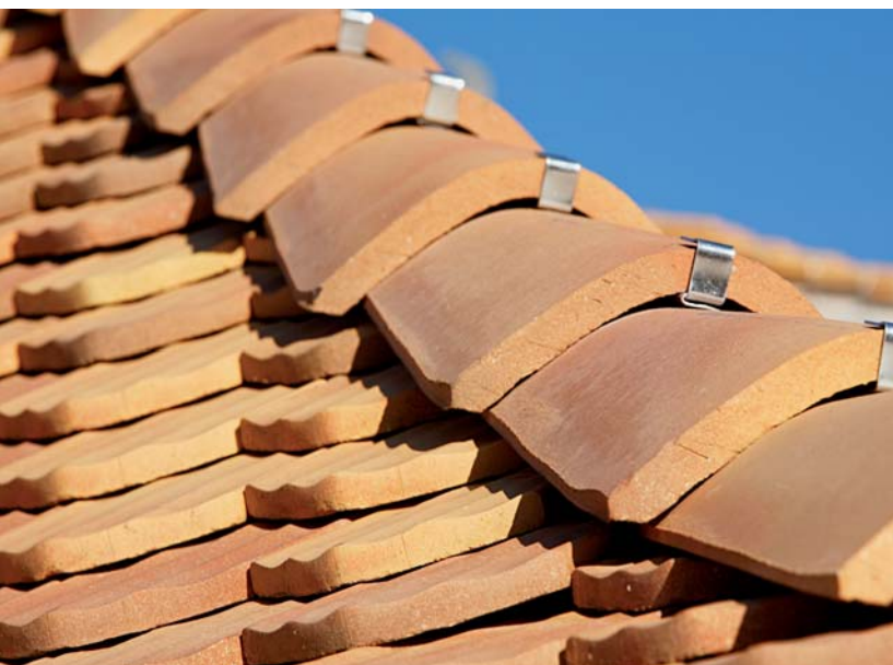
Alle Firstziegel sind für den sicheren Halt einzeln festgeklammert.
