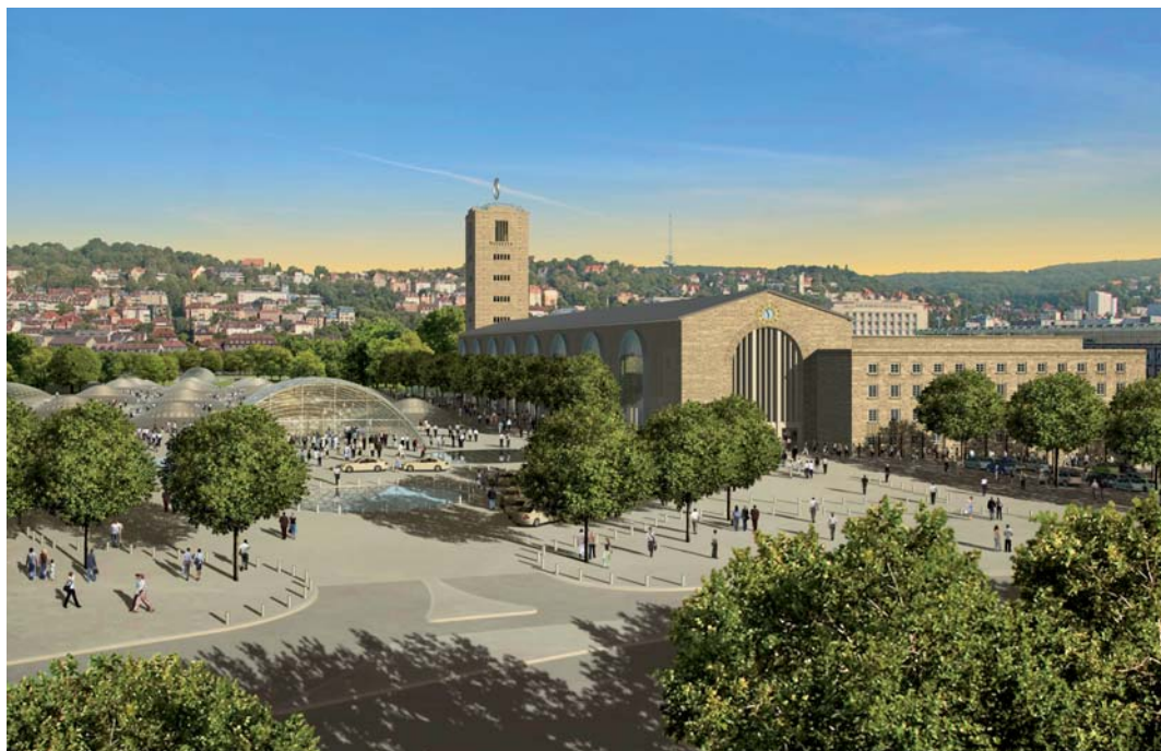
Platz und Umgebung des künftigen neuen Stuttgarter Hauptbahnhofs. Das Gleisfeld wird geräumt.
