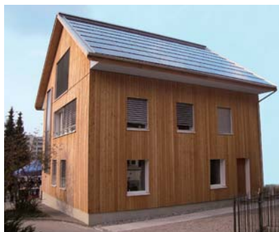
Dachintegrierte Solarstromanlage des Solarcenter Muntwyler in Horgen.
