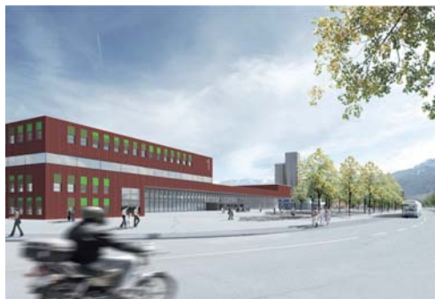
Zukunftsmusik: Nach Abschluss der Bauarbeiten für die Zentralbahn, wird die neue Halle 2 mitsamt Kopfbau erstellt.
