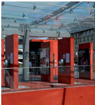
Auch der neue Berner Bahnhofplatz ist graffitigeschützt.
